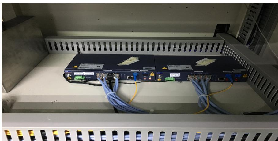
图 2-6 工厂生产设备侧部署 ONU
